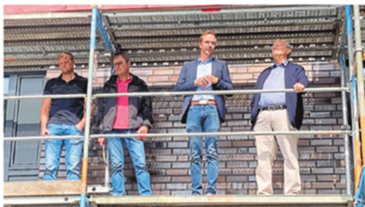
Richtfest beim Rathaus-Neubau in Warsingsfehn: Moormerlands Bürgermeister Hendrik Schulz begrüßt die Gäste. BILD: MAIKE HOFFMEIER
